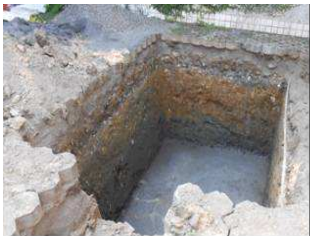
▲ 露天開挖作業，其垂直開挖最大深度超過 1.5 公尺以上，未設擋土支撐。
