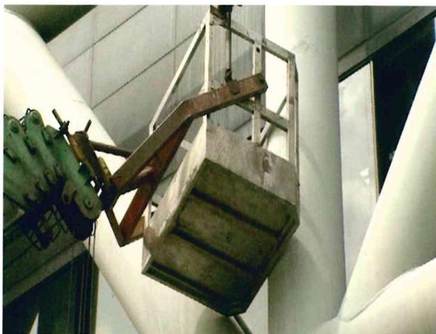
外伸撐座未伸出，施工時易造成力矩過大，造成工作車傾倒疑慮。
